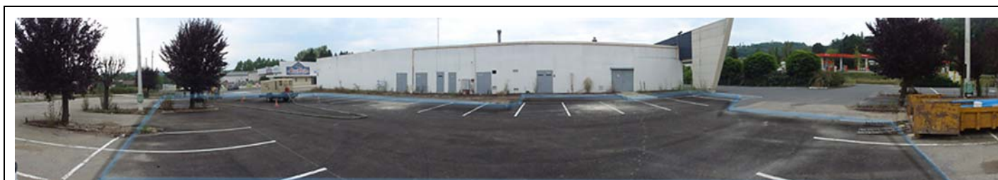
Fig.2 : Vue générale de la zone investiguée : parking, avec entouré de bleu, la zone dépolluée
